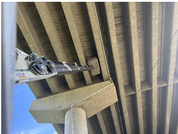
고소차를 이용한 근접조사
