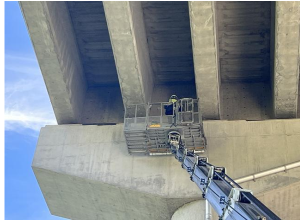
고소차를 이용한 근접조사
