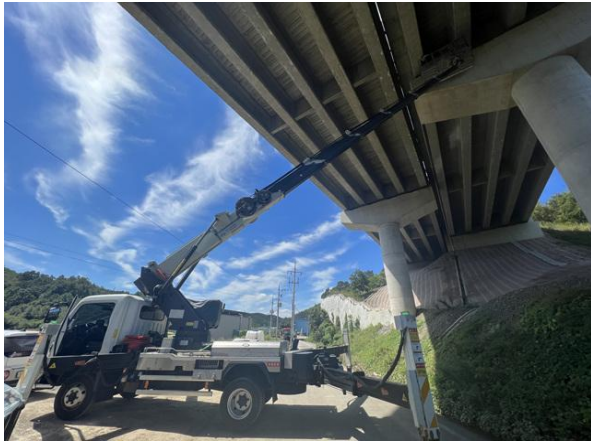
고소차를 이용한 근접조사
